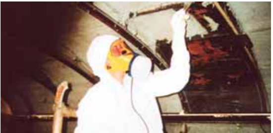
Asbestsanierung
